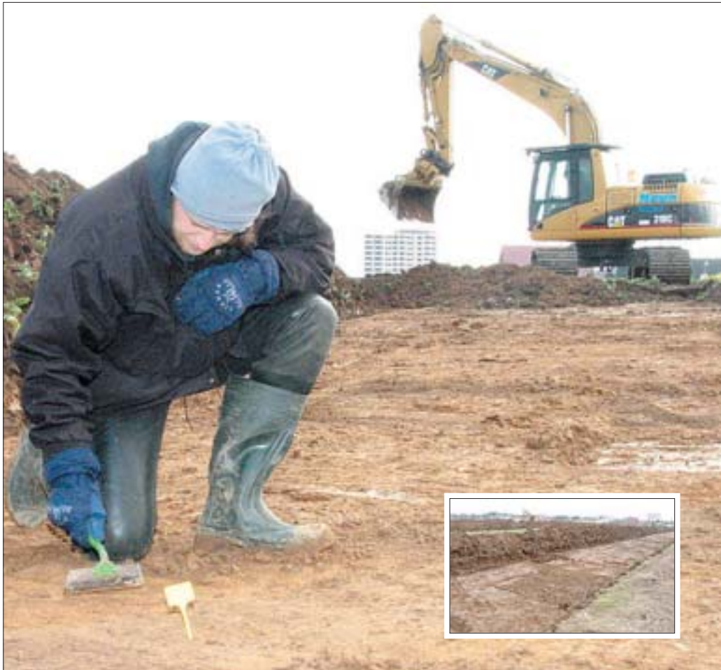
Archäologe Tobias Poremba (großes Bild) untersucht den Boden. Kleines Bild: Im Abstand von 20 Metern werden fünf Meter breite Suchschnitte ausgebagert. Krebs (2)
